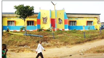
Vue partielle de la maison communale de Masina
